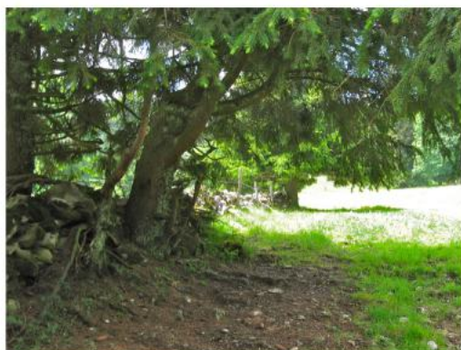
08 - Mur en pierres sèches
