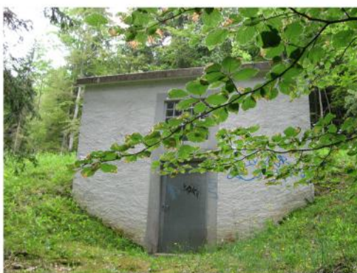
03 - Réservoir d'eau de Malvilliers
